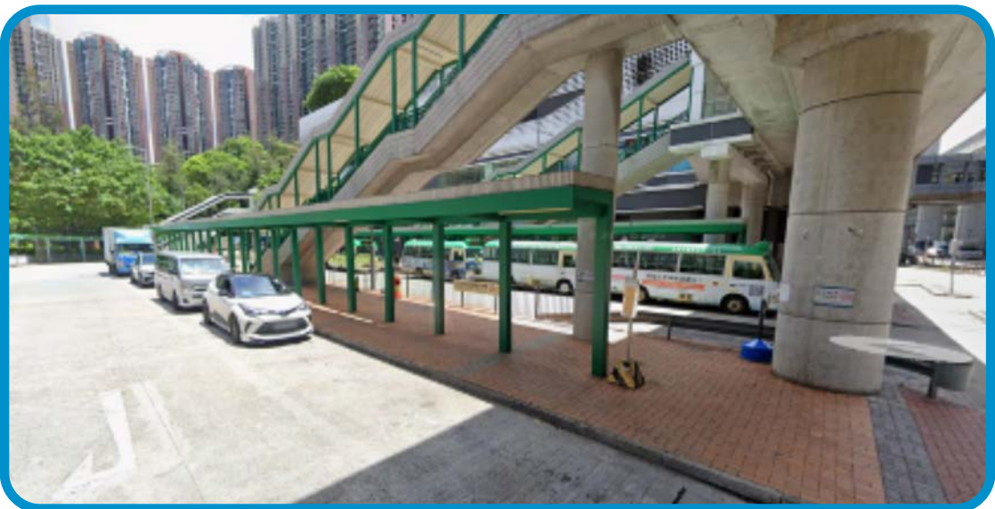
青衣港鐵站A1出口－近小巴士站
